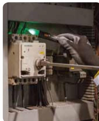
**Paso 3** - Si el LED verde se enciende con luz fija, la secuencia de fases es correcta. Si, en cambio la luz LED roja se enciende, la secuencia de fases es incorrecta.
