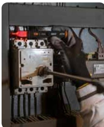
**Paso 1** - Apoye el HT70 en la asumida fase L1 del sistema trifásico (sobre el conductor o sobre el aislante) durante al menos **5s** y espere a que el **LED rojo** parpadee junto con el sonido del zumbador.
